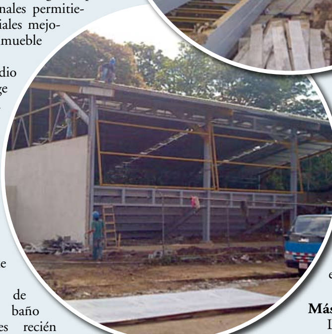
Así va la construcción del nuevo gimnasio del Liceo de Curridabat.
